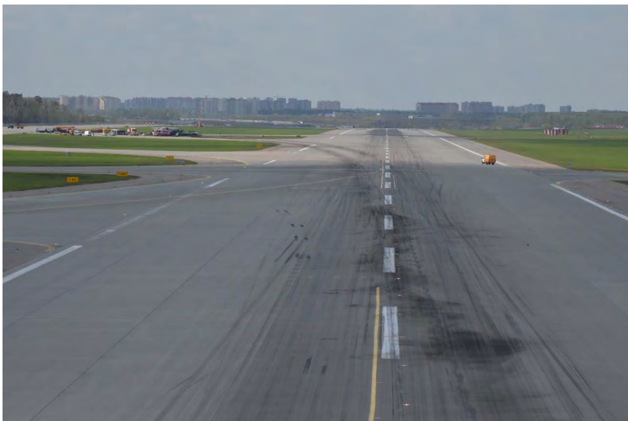
Рис. 38. Начало смещение следов влево от оси ИВПП в районе РД А5
