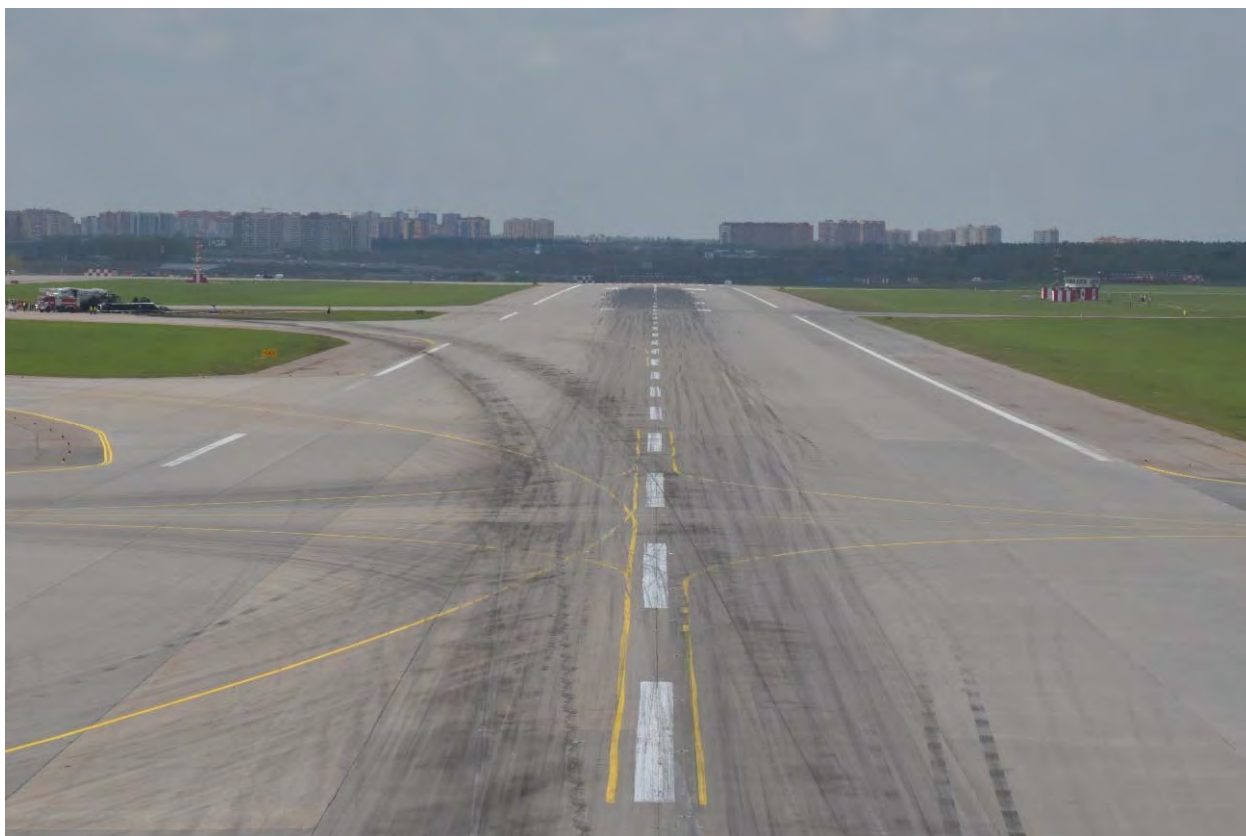
Рис. 39. Следы движения ВС, место выкатывания за пределы ИВПШ в районе РД А3
